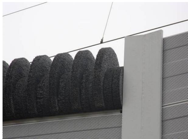
Bild 44: Beugekante als Aufsatzelement auf SSW
