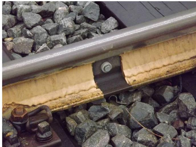
Bild 38: Beschichtetes Schienenstück
