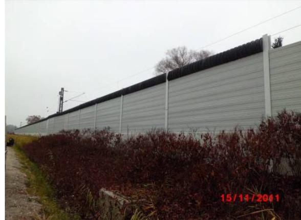
Bild 46: Ansicht Schallschutzwand mit Aufsatz Feldseite
