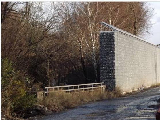
Bild 41: Gabionen-SSW mit FV in Duisburg
