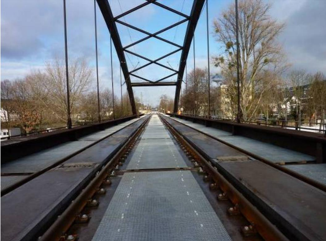
Bild 13: Direkt befahrene Stahlbrücke, Bsp. EÜ Lahnstein
