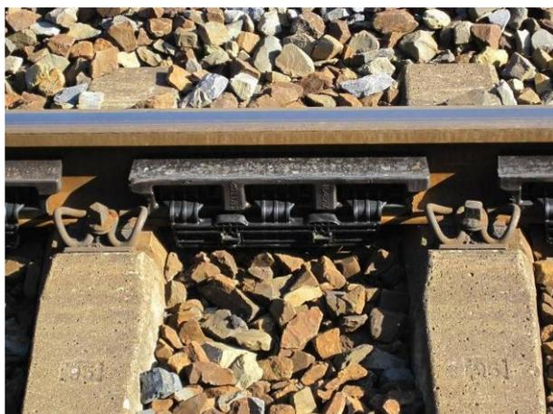
Bild 4: Beispielfoto für die Technologie Schienenstegdämpfer
