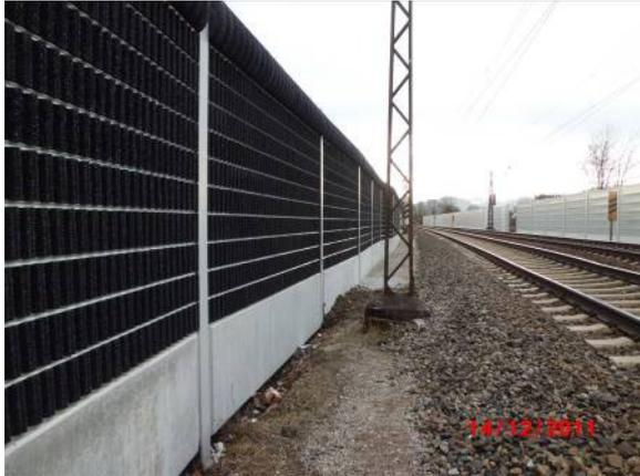
Bild 45: Ansicht Schallschutzwand mit Aufsatz Gleisseite
