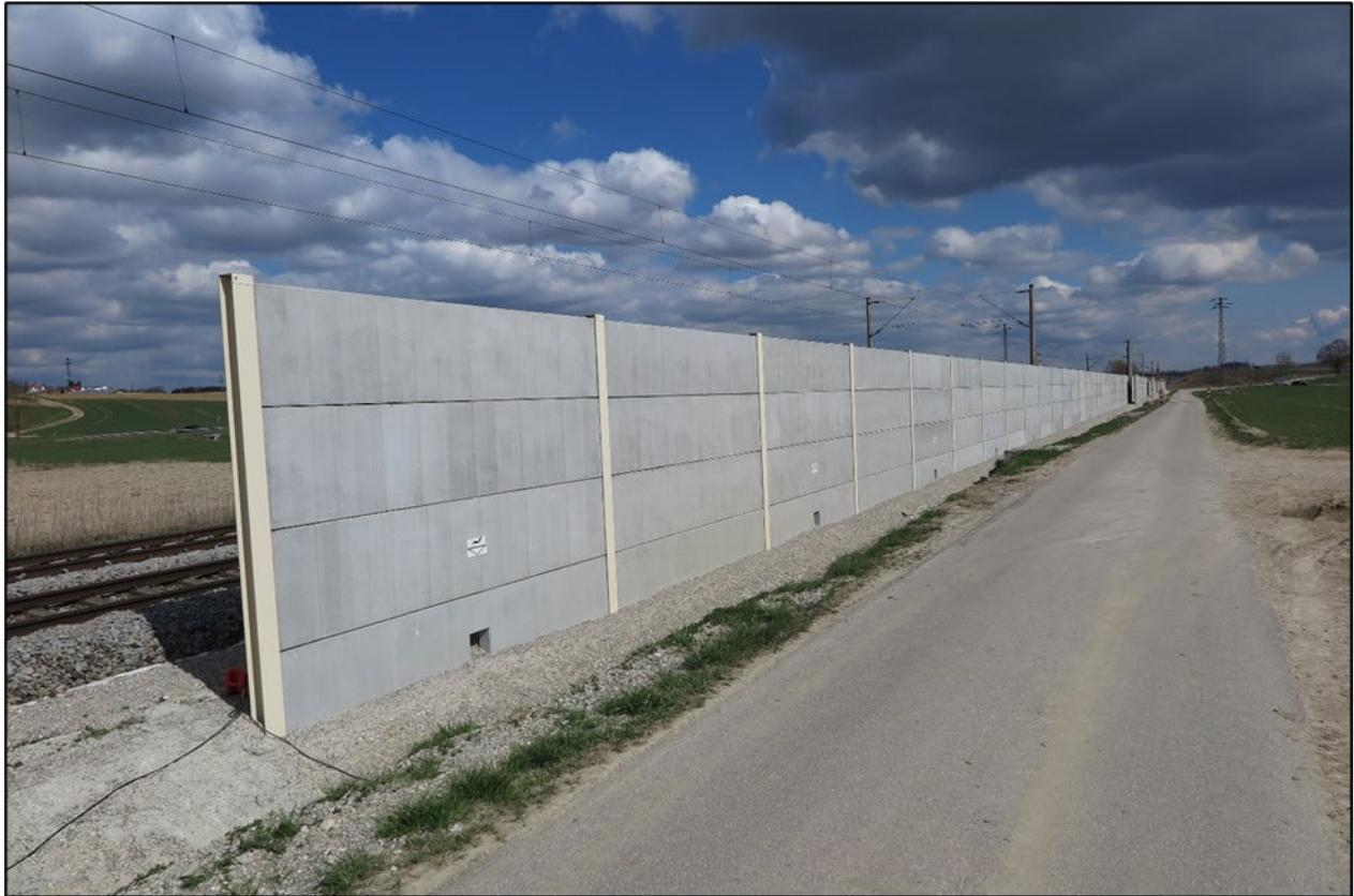
Abbildung 36: Schallschutzwand ohne Aufsatzelement im Referenzabschnitt.
