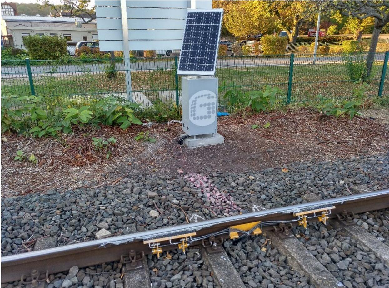
Abbildung 63: Schienenschmiereinrichtung in Grünstadt.
