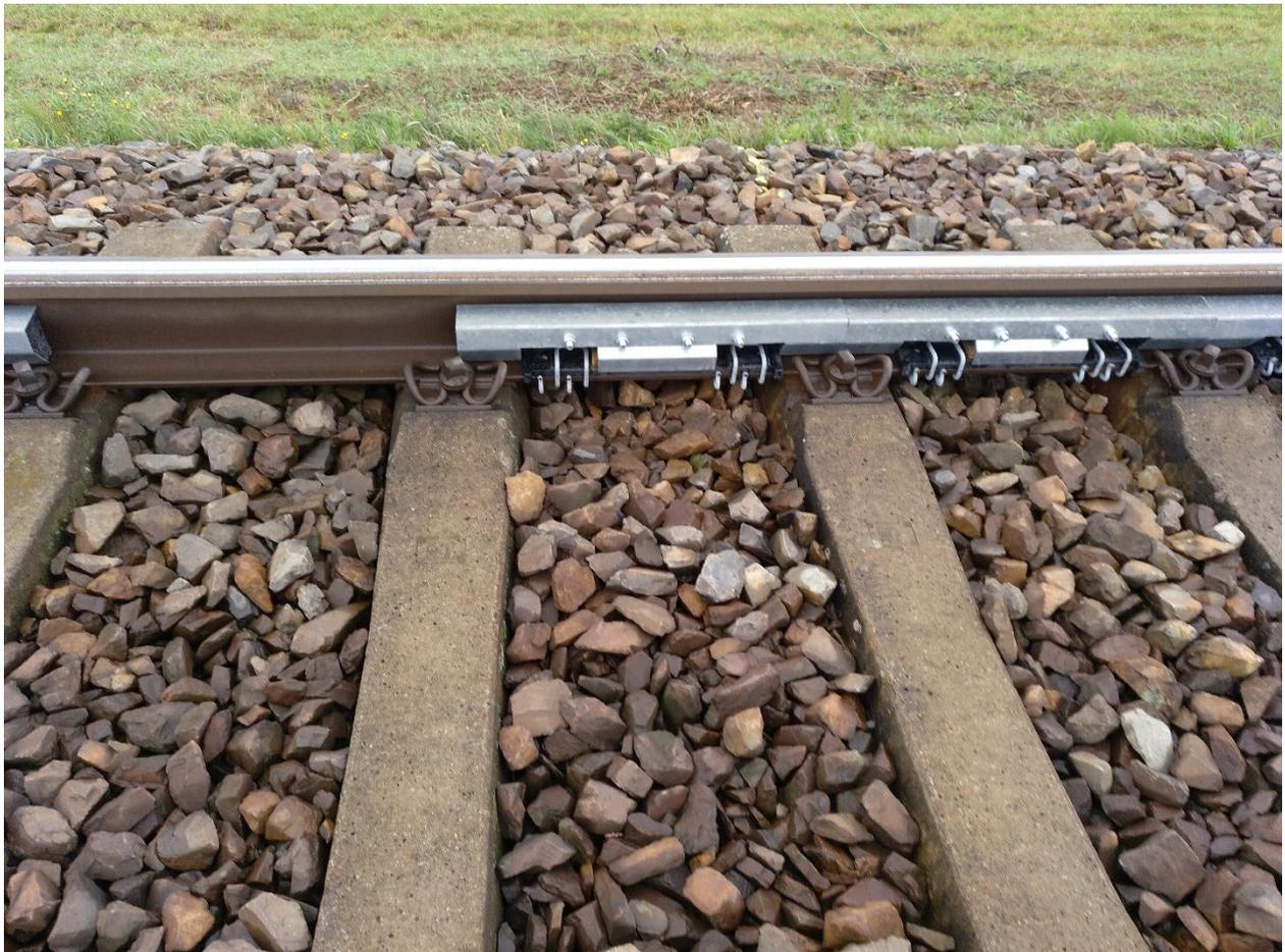
Abbildung 12: Kombination eines Schienenstegdämpfers mit einer Schienenstegabschirmung.
