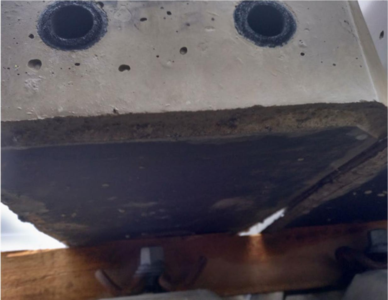
Abbildung 49: Schwelle mit optimierter Schwellensohle am Testabschnitt der Strecke 6153.
