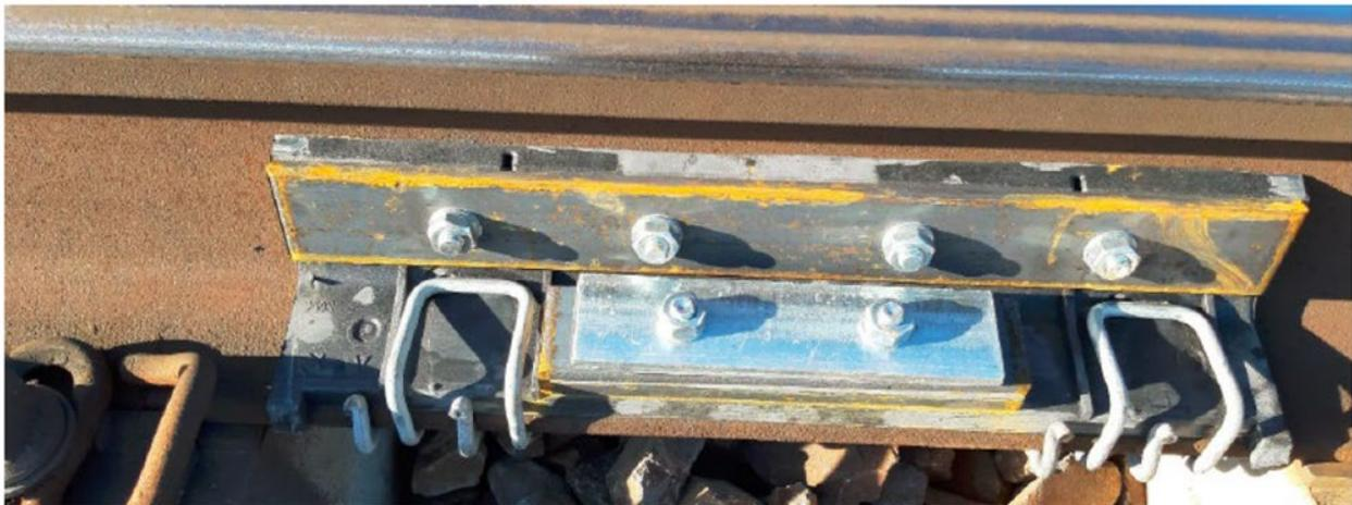
Abbildung 57: Schienenstegdämpfer, eingebaut im Testabschnitt.
