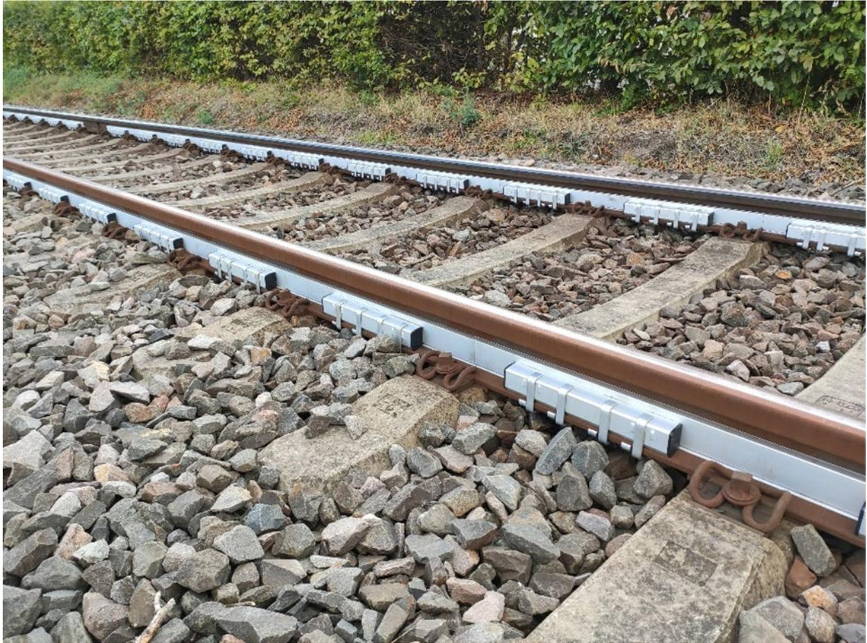
Abbildung 76: Schienenstegdämpfer gegen Kurvenquietschen bei Wachenheim.
