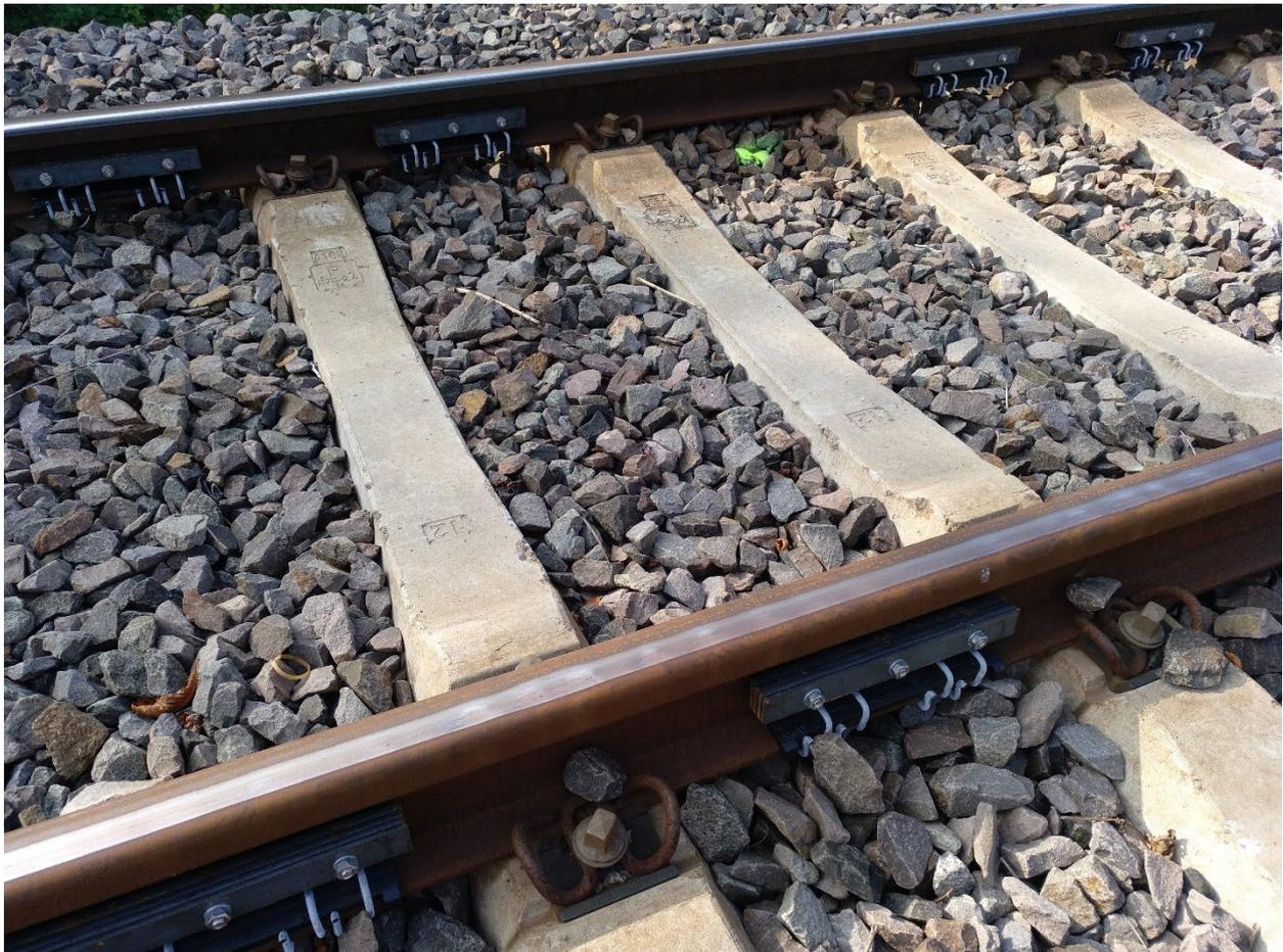
Abbildung 72: Schienenstegdämpfer gegen Kurvenquietschen bei Freinsheim.
