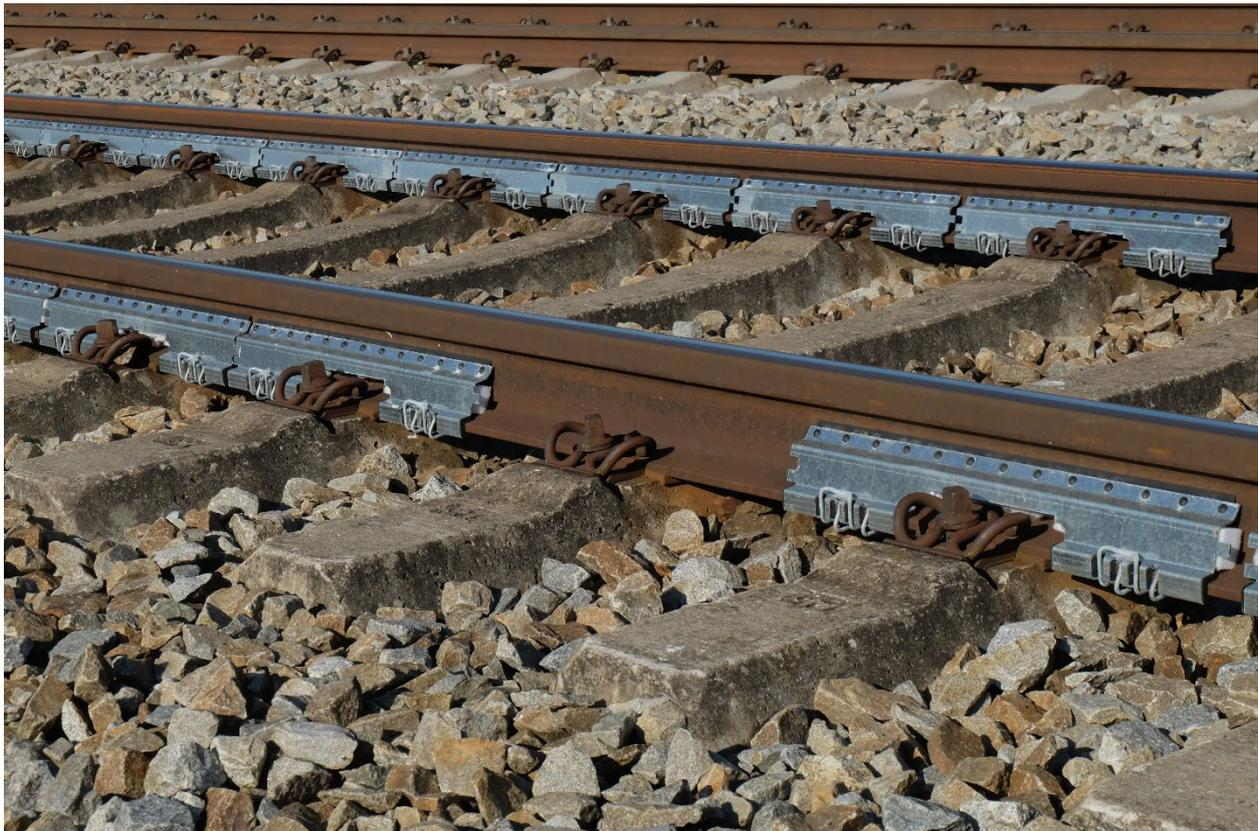
Abbildung 17: Foto der Schienenstegabschirmung installiert im Gleis.
