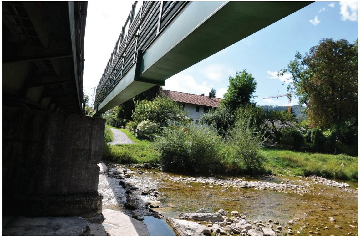
Abbildung 10: Lücke zwischen Eisenbahnbrücke über Auerbach und Schallschutzwand
