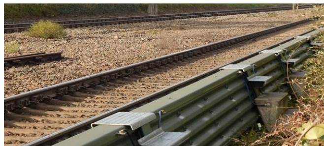
Abbildung 5.5: Niedrige Schallschutzwand, Höhe 55 cm über SOK
