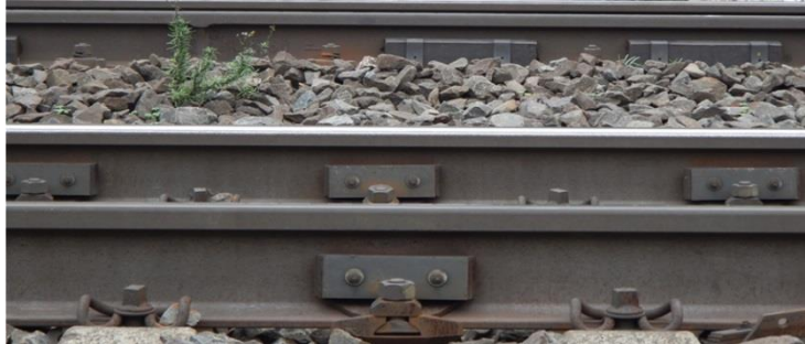
Abbildung 5.2: Schienenstegdämpfer unterschiedlicher Bauart in Koblenz
