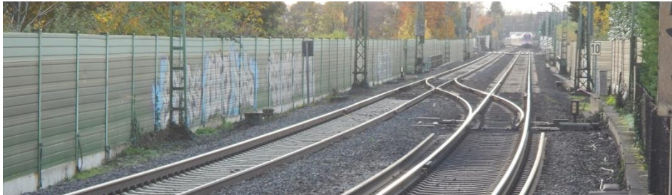
Abbildung 5.4: Schallschutzwand, Höhe 2 m über SOK
