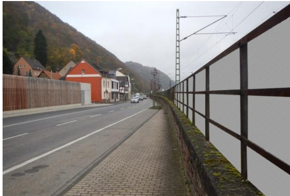
Abbildung 5.6: Geländer mit schematischer Geländerausfüllung (grau)
