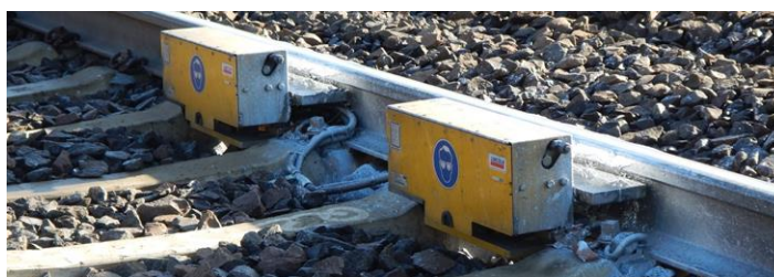
Abbildung 5.7: Schienenschmiereinrichtung
